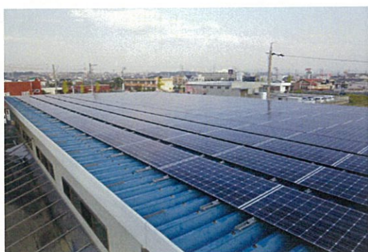
製造部屋根への太陽光発電設備設置 事務所ガラス面への日射調整フィルム施工
